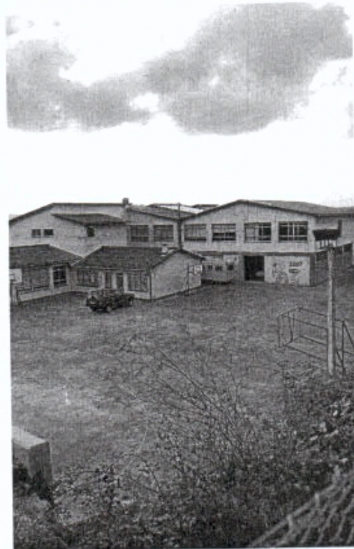
Las lluvias de los últimos meses dañaron las instalaciones
